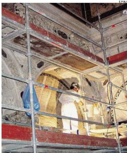
► I lavori all'interno dell'Arca
