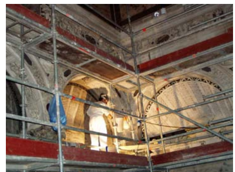
Restauro Cappella dell'Arca del Santo
